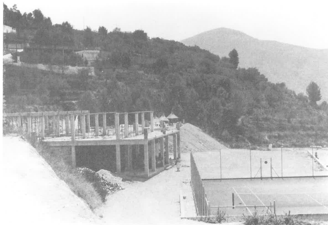
El inicio de las obras del local social del Club de Camp Bixquert
