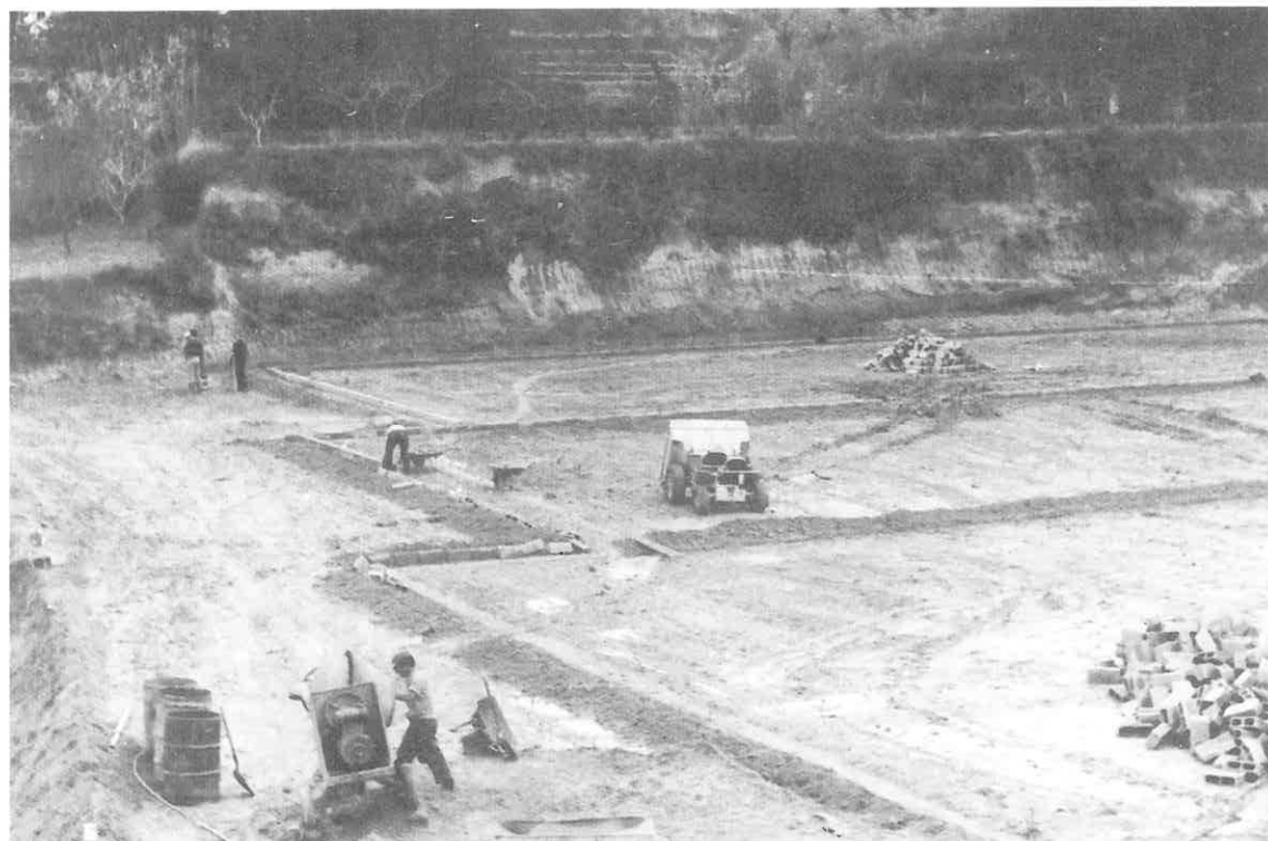
Inicio de las pistas de grava, futuras pistas duras.
