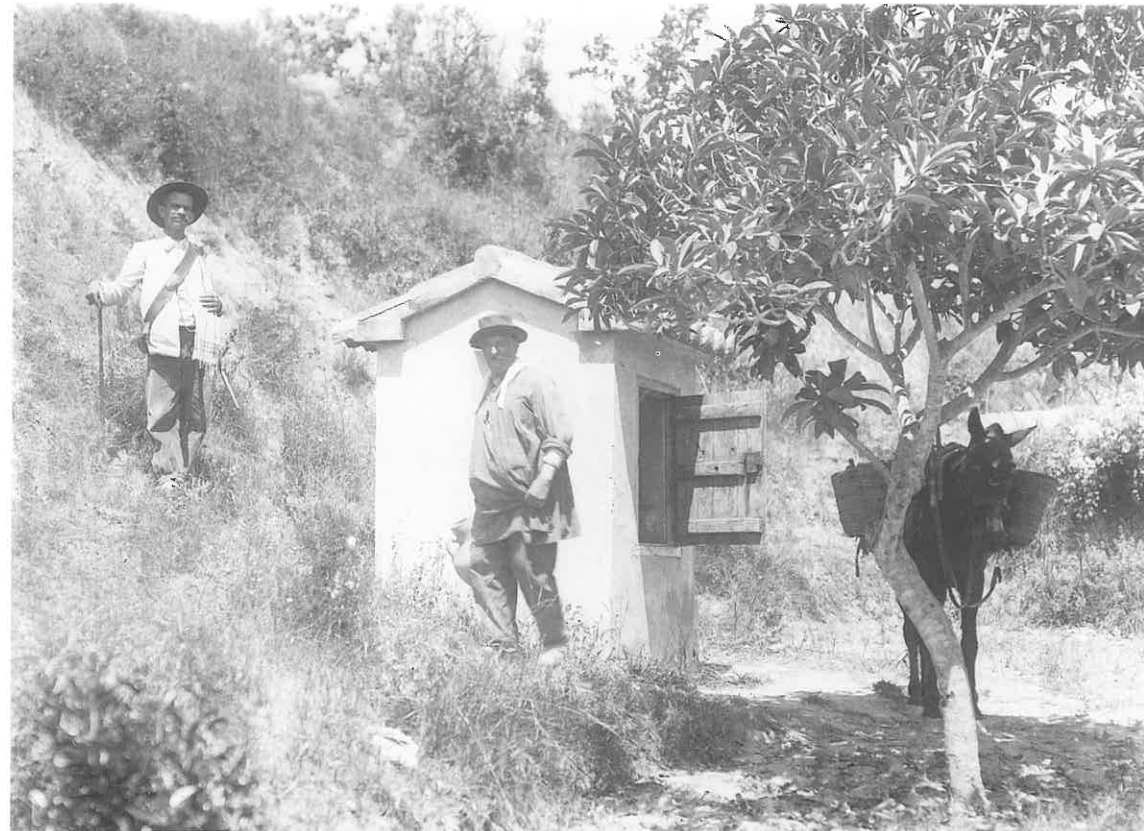
La modernización de los pozos transformó el inhóspito "secà" en un fecundo vergel (Del libro Xàtiva. Records d'una època. 1900.1935)
